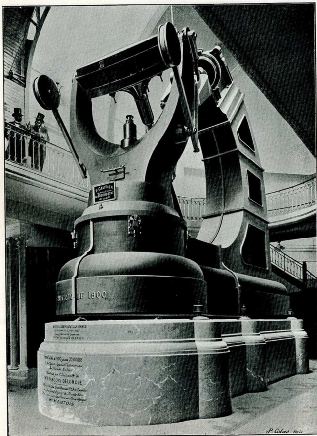
Fig. 4. — Siderostat avec miroir plan de 2 mètres.
